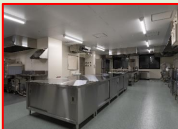
厨房・職員食堂
